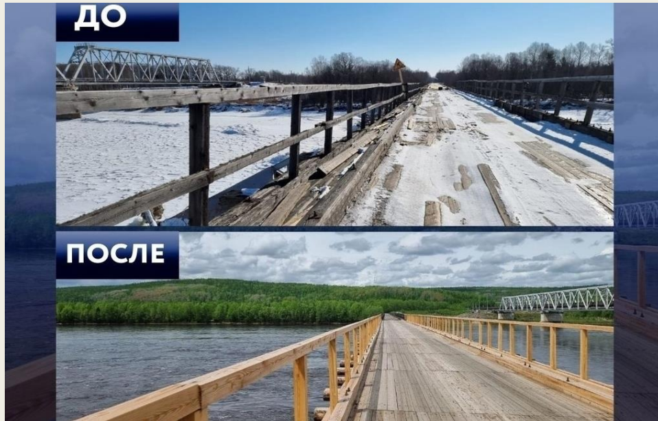
Ремонт моста через р. Бурея
