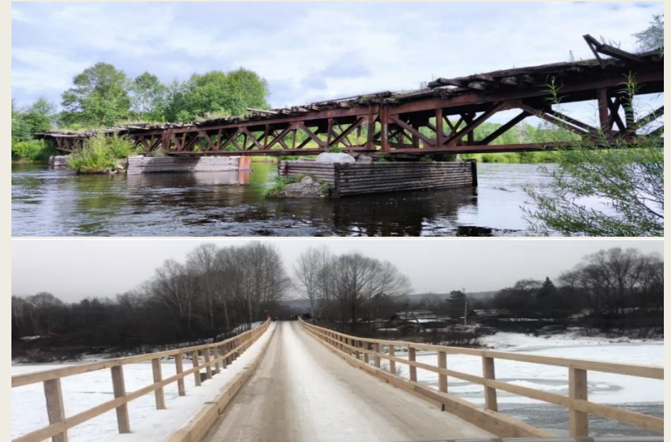
Ремонт моста через р. Сутырь
