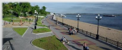
Реконструкция набережной г. Хабаровска (IV этап)
