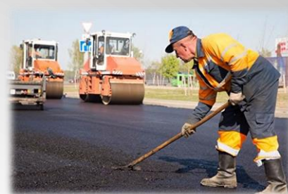
Приведение в нормативное состояние улично-дорожной сети (1, 2 этапы)
