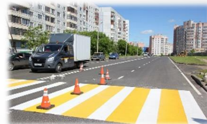
Ремонт 90,6 км автодорог Хабаровской и Комсомольской агломераций
