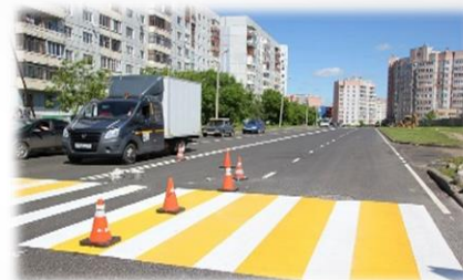
Ремонт 90,6 км автодорог Хабаровской и Комсомольской агломераций
